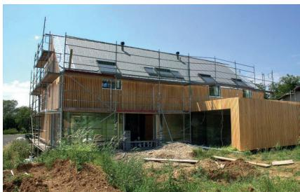
Bei diesem Einfamilienhaus wurden alle Wände, Decken und Teilbereiche des Daches als Massivholzkonstruktion erstellt. Anschließend wurde auf die Außenwände eine Unterkonstruktion mit Holz-Stegträgern montiert, die mit Holzfaser ausgeblasen bzw. gedämmt und mit einer vorgehängten Holz-Lamellenfassade bekleidet wurde. Im Innenraum
