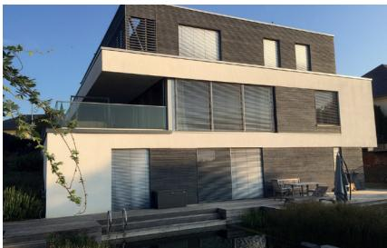
Das Haus ist als Holzständer- bzw. Holzrahmenkonstruktion gefertigt. Die Holzrahmenkonstruktion wurde sowohl im Dach als auch in den Außenwänden mit Holzspänen ausgeblasen bzw. gedämmt. Zu der 35 cm starken Wandkonstruktion wurden zusätzlich 16 cm starke Holzfaserplatten aufgebracht, welche der Außenwand einen außerordentlichen
