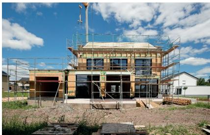
Die Außenwände bestehen aus 10 cm Massivholz, 24 cm Zellulosedämmung und 6 cm Holzfaserdämmplatte. Die Fassade wird teilweise verputzt und zum Teil mit Keramikplatten bekleidet. Das Dach ist in der Sparrenebene mit Holzweichfaserplatten gedämmt. Nach außen bildet eine Holzfaserplatte das regendichte Unterdach, nach innen eine mit Gipskarton bekleidete OSB-Platte, die luftdichte Ebene. Die Decken bestehen ebenfalls aus Massivholz.
