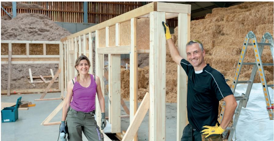
*Ce projet pouvait déjà être visité lors des semaines de l'énergie en 2019. A ce moment on a pu observer en démonstration une partie de la structure en bois et paille de cette maison bioclimatique qui est réalisée en auto-construction suivant le principe du chantier participatif.*
